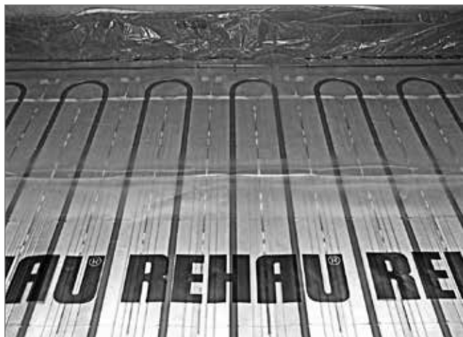
Рис. 16-1 Система укладки труб на теплоизоляционных матах TS-14
