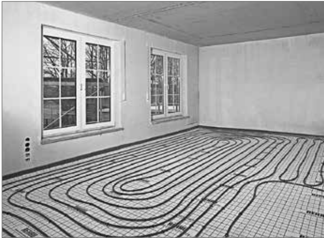
Рис. 15-33 Система крепления труб с помощью гарпун-скоб
