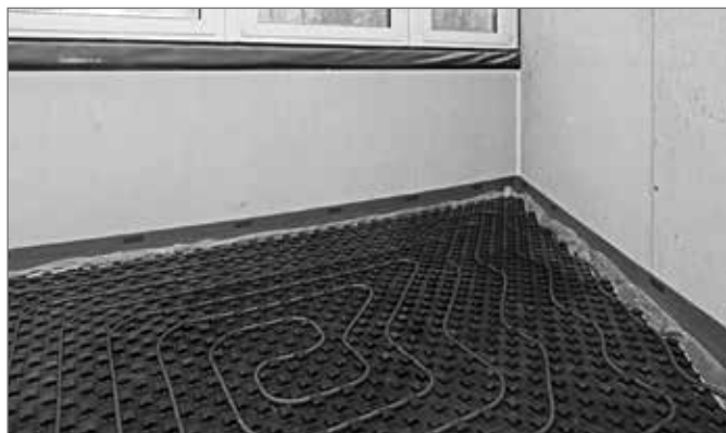
Рис. 15-22 Маты с фиксаторами Varionova с шагозвукоизоляцией 30-2 снизу
