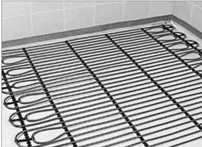
Рис. 15-67 Напольная фиксирующая шина для «мокрого» способа монтажа
