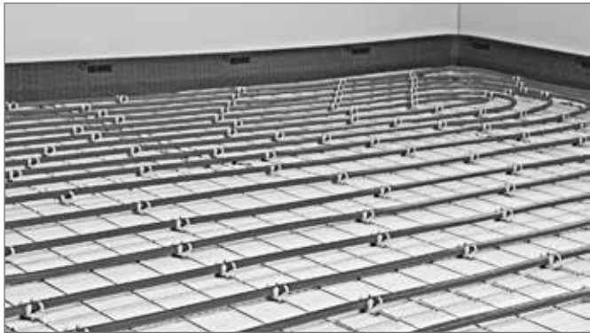
Табл. 15-30 Система крепления труб на арматурной сетке
